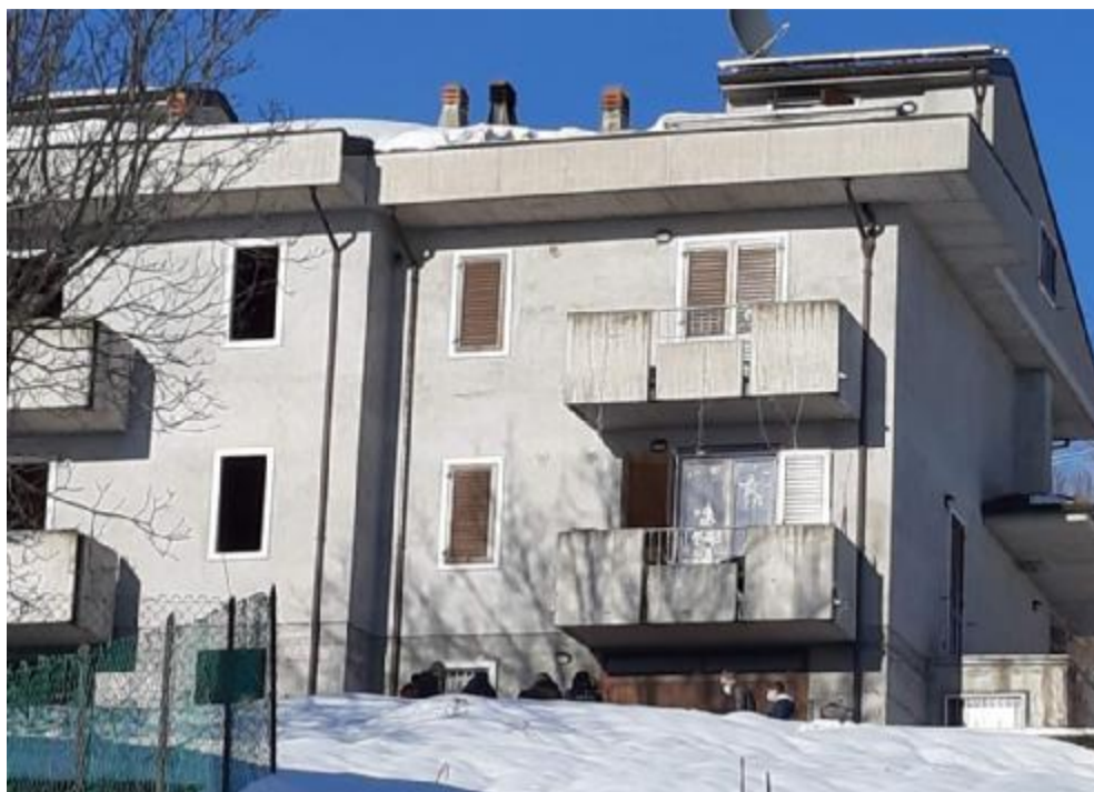
L'edificio dal quale è precipitato Tiziano Ramponi l'ultimo giorno dell'anno
