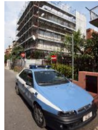
La polizia davanti a un cantiere
